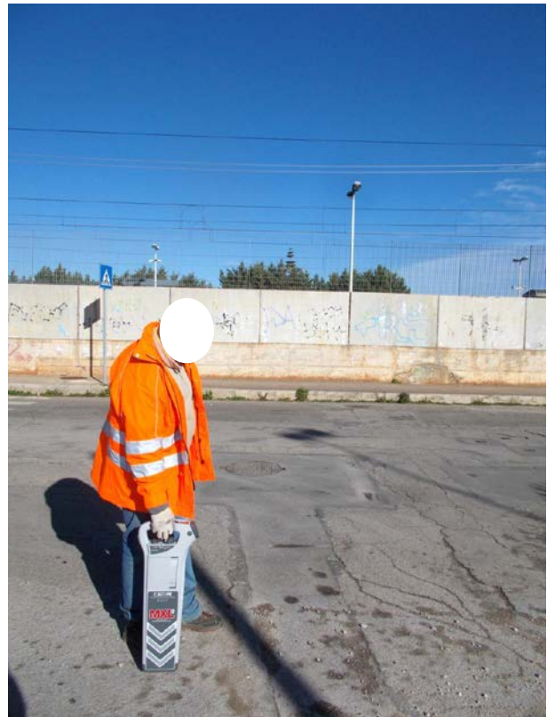
Screening dei cerca servizi è stato utilizzato il localizzatore C.Scope MXL2
