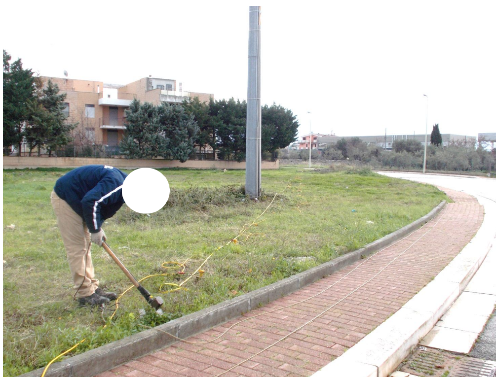
Energizzazione con mazza battente onde longitudinali (onde P)
