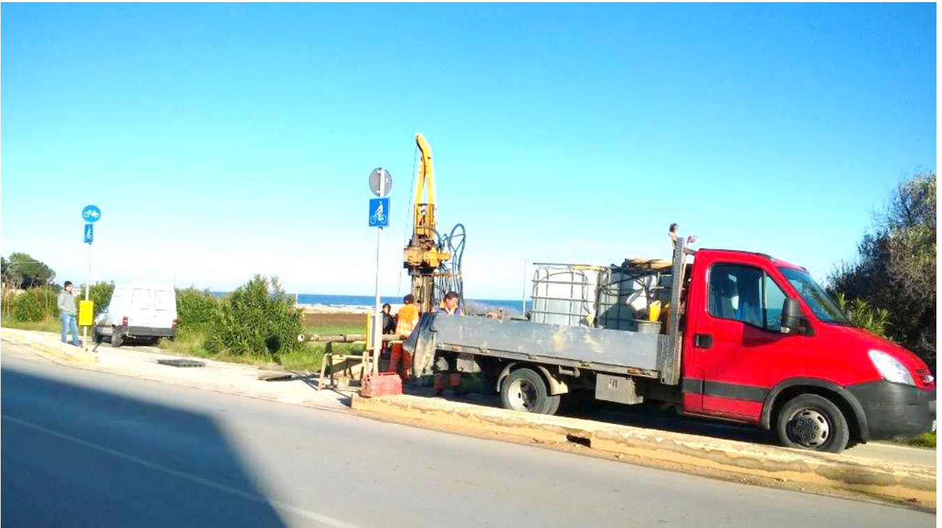
Postazione sondaggio S1
