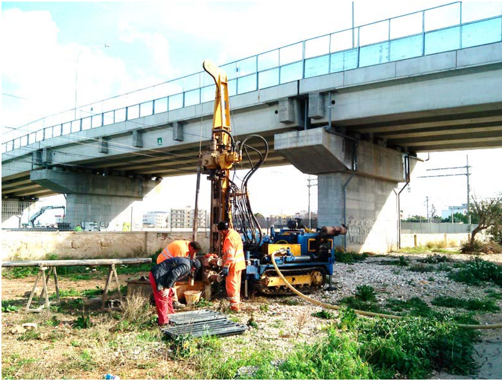
Postazione sondaggio S2
