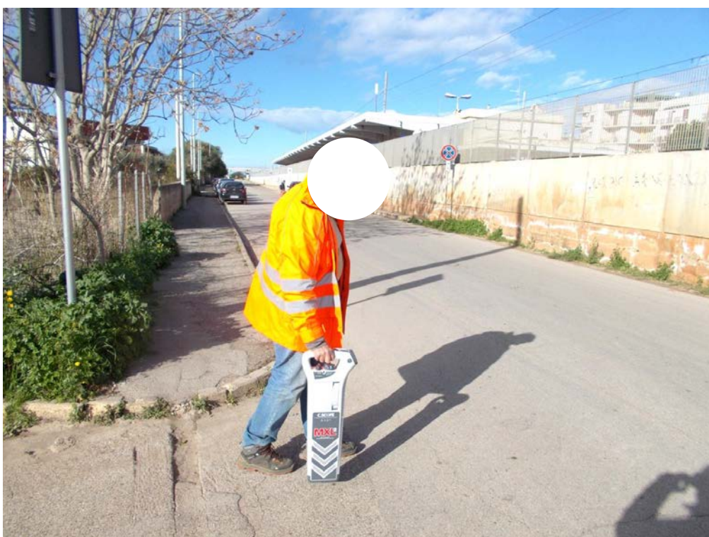
Screening dei cerca servizi è stato utilizzato il localizzatore C.Scope MXL2
