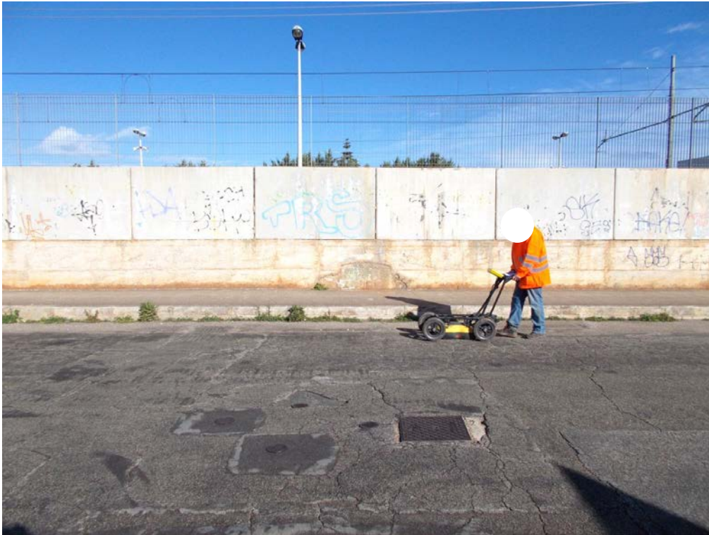
Sistema radar "NOGGIN 250" della Sensors & Software Inc.
