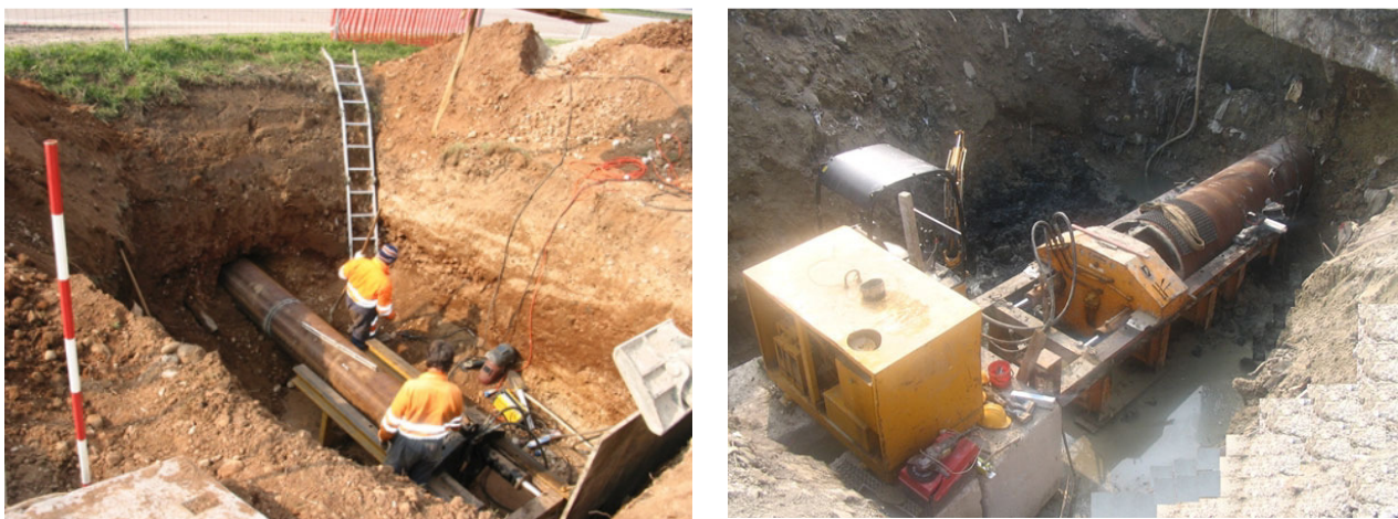
Figura 2 – Posa in opera di tubazioni mediante la tecnica dello spingitubo
