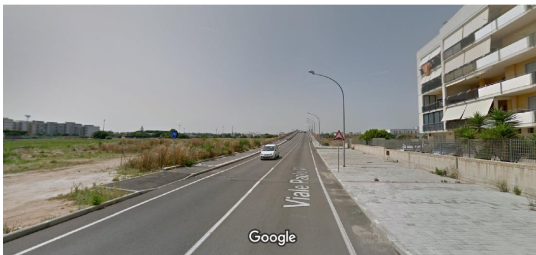
Figura 42 - L'inizio della ciclabile sul nuovo cavalcaferrovia di Viale Paolo VI, quartiere Cozzetto
