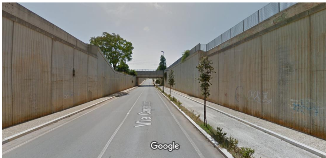
Figura 39 - Percorso ciclabile protetto e spartitraffico verde nel nuovo sottopasso di Via Caracappa
